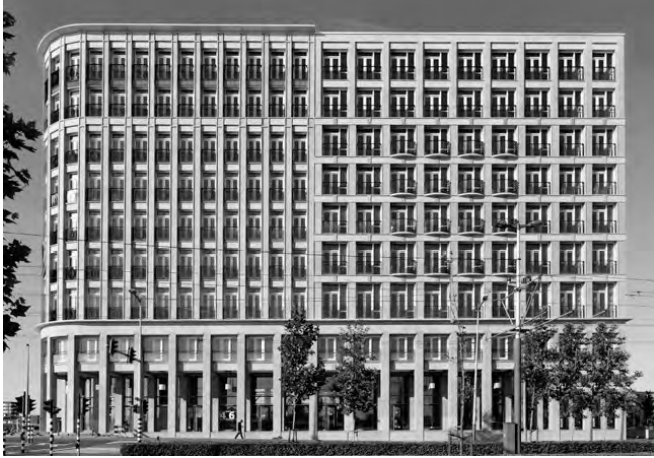
Fig.111. Opération Solid réalisée par Baumschlager-Eberle sur l'île artificielle d'IJBurg
