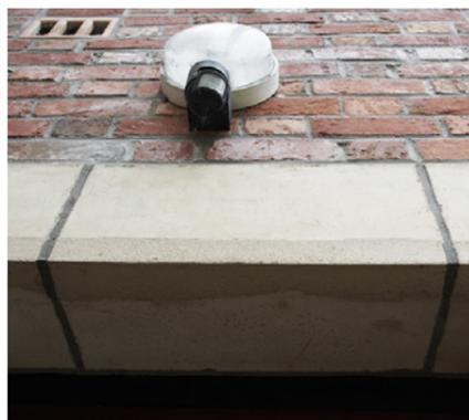
Figure 44 : les blocs de béton blanc préfabriqués unifient le projet
