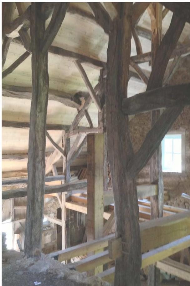
Fig. 26 Restauration des charpentes des fermes jumelles
