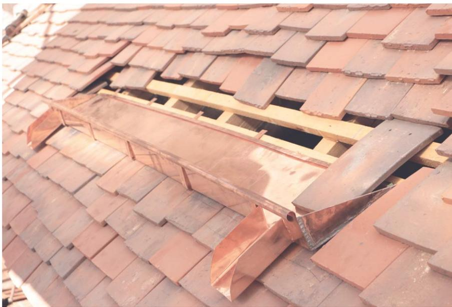
Fig. 27 Pose de chéneaux nantais en cuivre sur les salines royales
