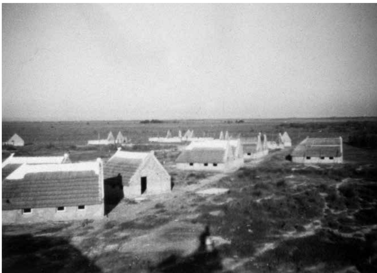
11. Le camp en construction © AD13 142 W 76
