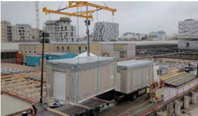
4. Mise en place des modules, © Pavillon de l'Arsenal.
