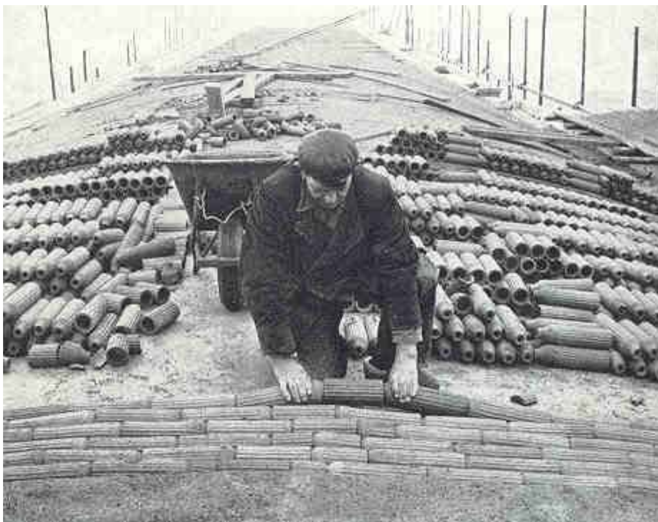
10. Mise en place d'une voûte en « fusées-céramique » © Jacques Couëlle
