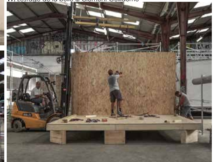
20. Construction d'une chambre © Arthur Crestani
