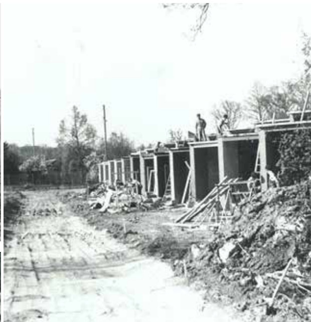
3. Photo du chantier, mai 1954, ©Emmaüs Habitat.
