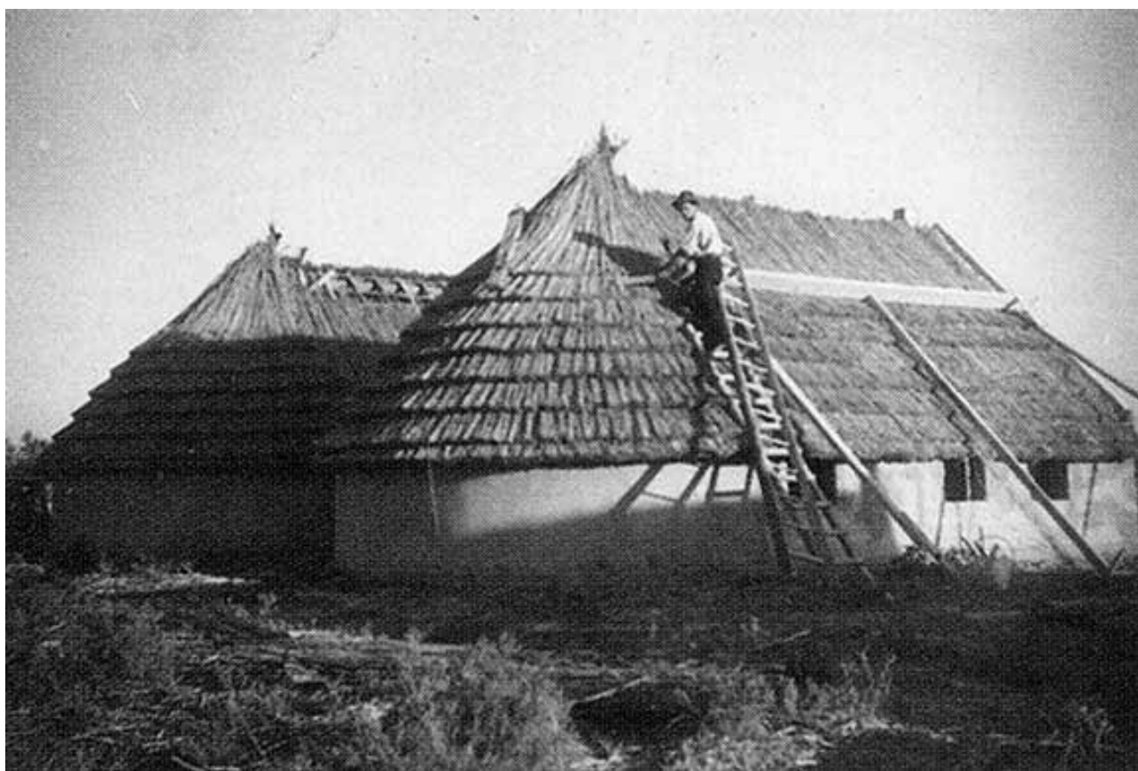
6. Vue de la construction d'une cabane dans le camp de Saliers, 1942 © Francis Bertrand
