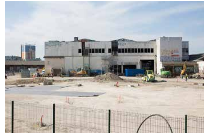
15. Le bâtiment en plein transformation © Clément Guillaume
