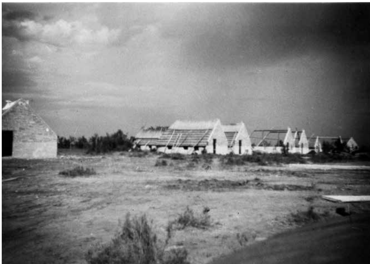
10. Le camp en construction © AD13 142 W 76
