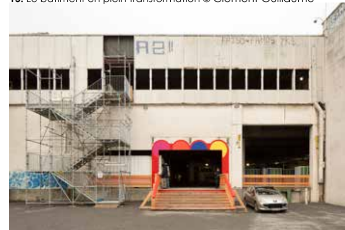
16. L'entrée du pôle hébergement © Clément Guillaume
