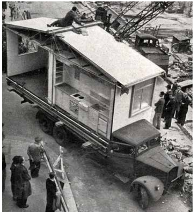
4. AIROH prefabricated house: une des quatre sections de la maison étant mise en oeuvre, Londres, 1945, © RIBA Collections
