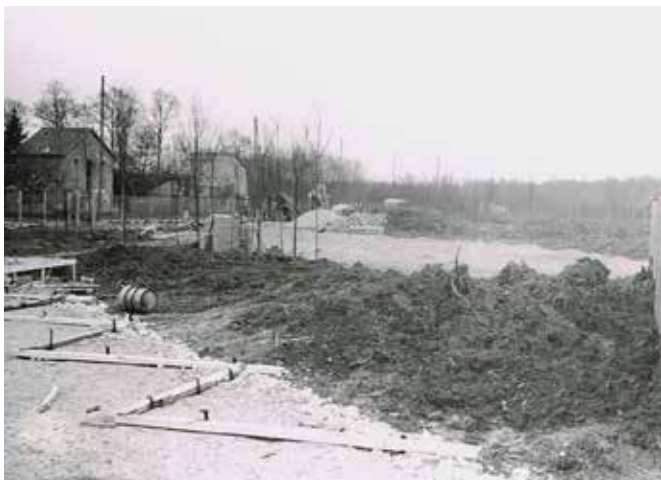
1. Photo du chantier, mars 1954, © Mémoires du Plessis-Trévisé.
