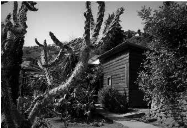
2. Vue du Cabanon, © ofHouses
