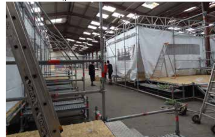
18. Les échafaudages à l'entrée des quartiers © Frédéric Keiff
