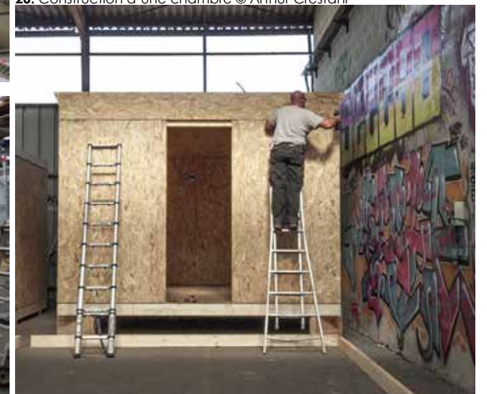
21. Construction d'une chambre © Arthur Crestani
