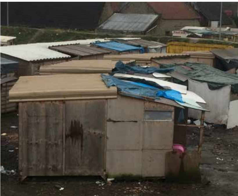
19. Un shelter et ses extensions, mars 2017 © Violaine Eggermont - ENSAPB - Studio « La ville accueillante »
