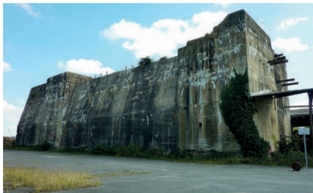
fig. 78 — Thierry Llsansades, Bordeaux, vestiges seconde guerre mondiale, soute à gasoil , 2014, flickr
