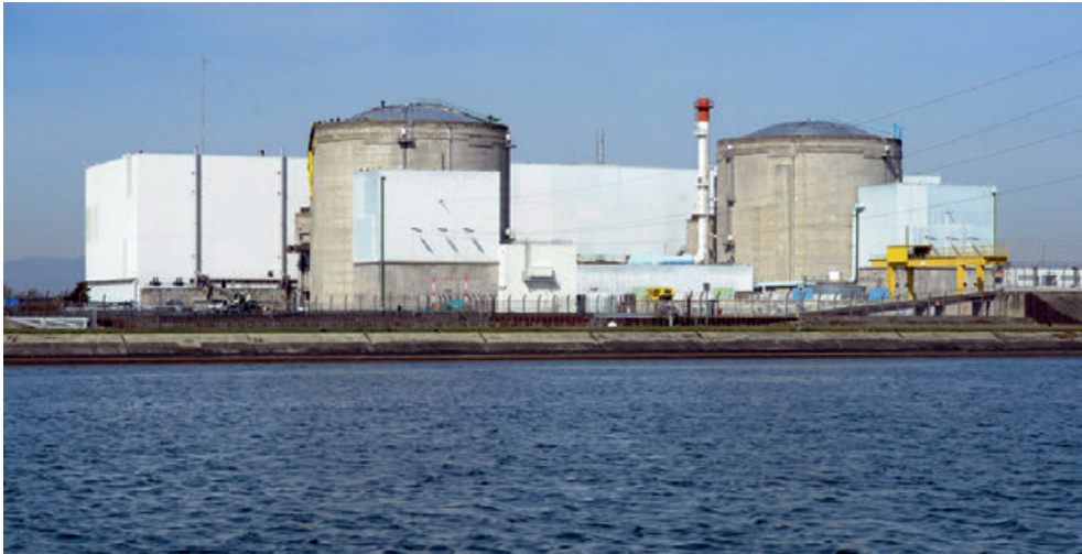
fig. 52 — Centrale nucléaire de Fessenheim, 2014
