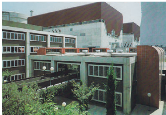
fig. 154 — Paul Andreu, Bâtiments annexes, Centrale nucléaire de Cruas, Les maisons de l'atome
