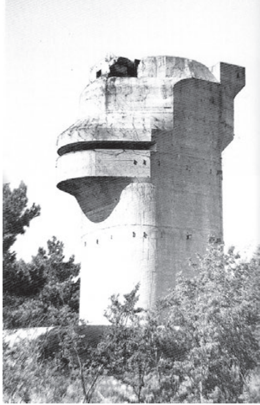
fig. 79 — Paul Virilio, «Karola» tour de direction de tir sur l'atlantique, Bunker Archéologie , 1975
