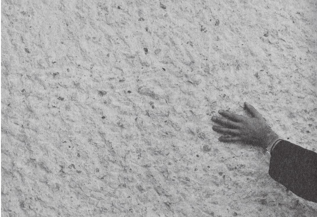
Fig/ 49 : Béton cyclopéen - Rugosité du Béton - Mémorial de Paris
