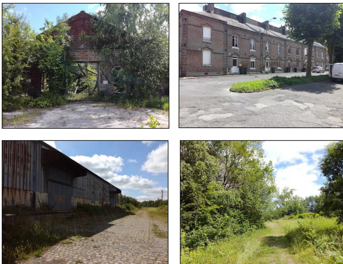
Fig. 1. Photographies du site du projet.
