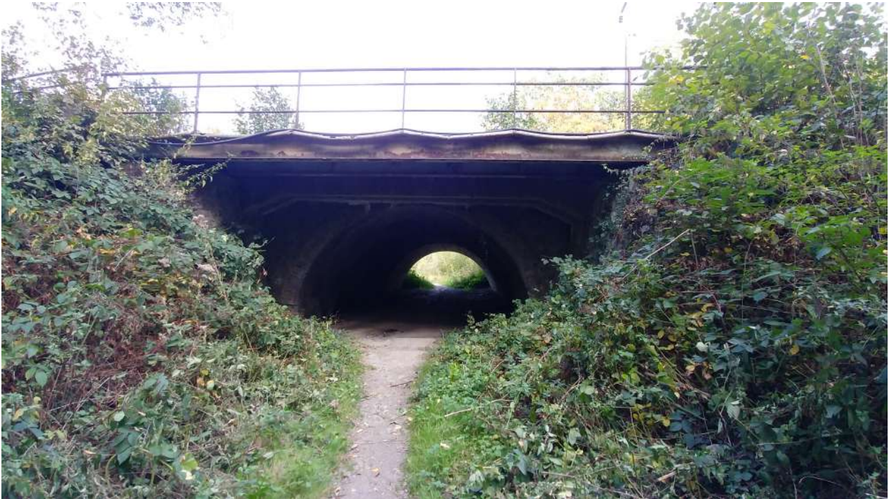
■ PASSAGE EXISTANT SOUS VOIES FERRÉES VERS L'HÔPITAL
