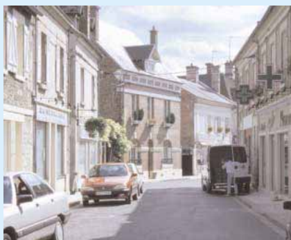
Le centre est constitué de facettes architecturales où chaque façade semble jouir d'une indépendance formelle.
