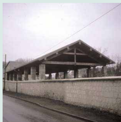
Grange et mur de pierre dans le village de Coyolles
