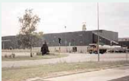
L'usine "Greenfield" à Château-Thierry. Dès cette époque, le développement industriel qui s'amorce bouleverse certaines perspectives visuelles aux abords des grandes villes.
