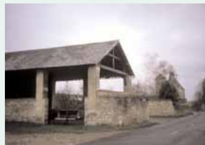
Hangar agricole dans le village de Largny
