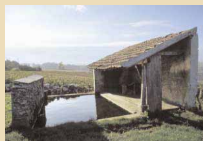
De nombreux lavoirs sont présents dans les villages ou à l'extérieur signalant ainsi l'importance de l'eau dans cette unité
