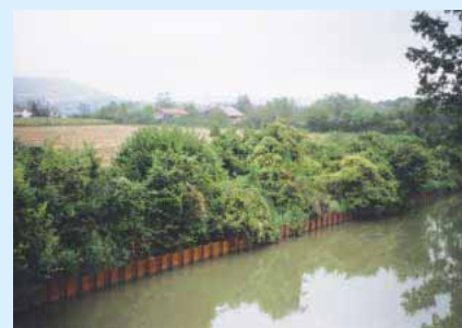
Le canal et sa végétation arbustive et arborée maintenue par des soutènements. Un chemin de halage permet de longer cette voie d'eau.
