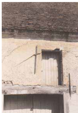
Détails de fissures, délabrements sur les façades de maisons d'habitations ou de fermes.
