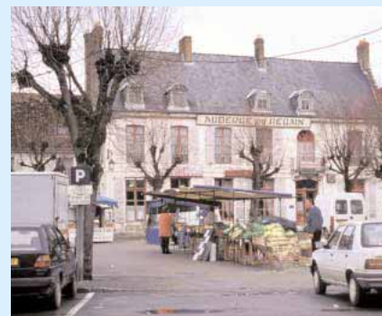
Les façades bourgeoises rythmées par de nombreuses baies, définissent de vastes espaces publics qui rappellent le passé commercial de première importance locale de la ville.
