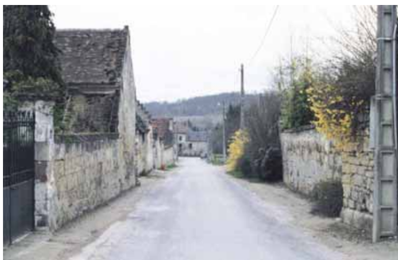
Les murs de clôtures, très présents dans le Soissonnais, donnent une densité aux fronts bâtis en assurant aux espaces publics une homogénéité d'une grande qualité. (Septmonts)
