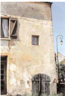
Détails de fissures, délabrements sur les façades de maisons d'habitations ou de fermes.
