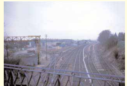
Dans les vallées qui découpent le plateau, s'installent les infrastructures telles les voies ferroviaires
