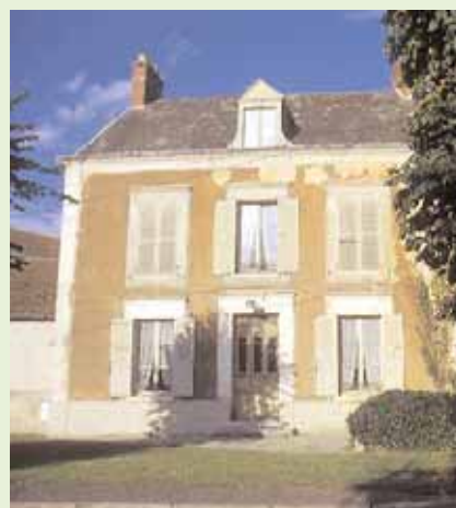
Les enduits au plâtre gros sont l'exclusivité du Tardenois et de la Brie
