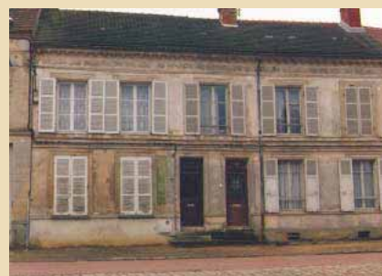
Les typologies urbaines façonnent des espaces minéraux denses rythmés par les baies et les modénatures élaborées
