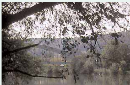
Pont de Jaulgonne sur la Marne
