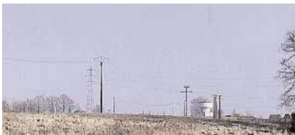
Les réseaux aériens et le chateau d'eau sont dominants dans la mémorisation de ce paysage. panneaux de signalisation et de sécurité.
