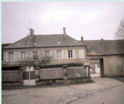
Le village de Lagny, avec ses fermes fortifiées, ses granges où le regard glisse entre les poteaux carrés qui supportent une belle charpente, ...
