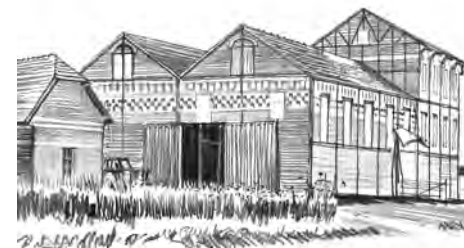
Ancienne râperie à structure métallique. Liéramont
