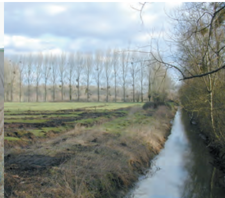
L'oeuvre du dessèchement Canal de dessèchement de l'Authie
