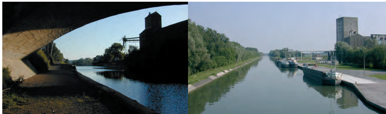
Canal de la Somme : une activité commerciale en déclin (Silos à l'amont de l'écluse de Froissy)
