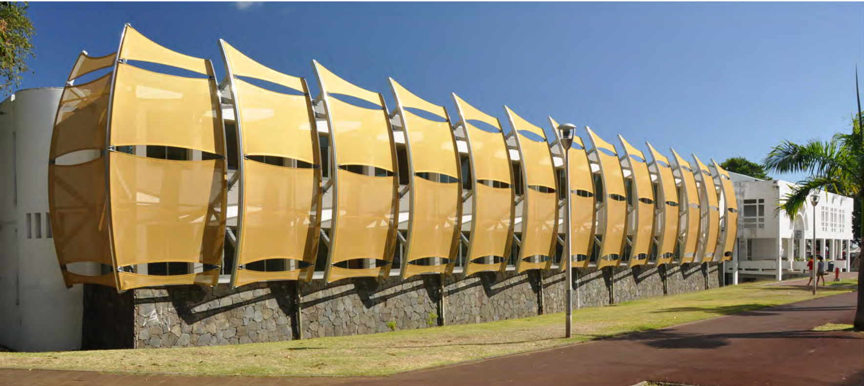
centre des finances publiques de Saint Denis
