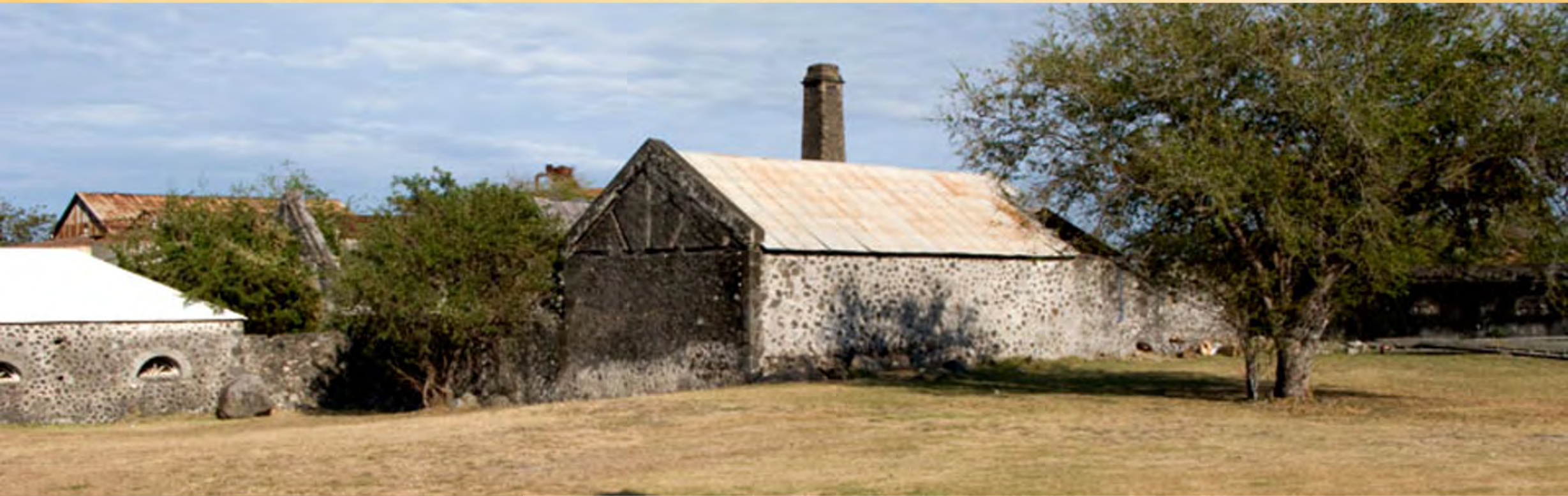
longère de l'ancienne usine de Pierrefonds
