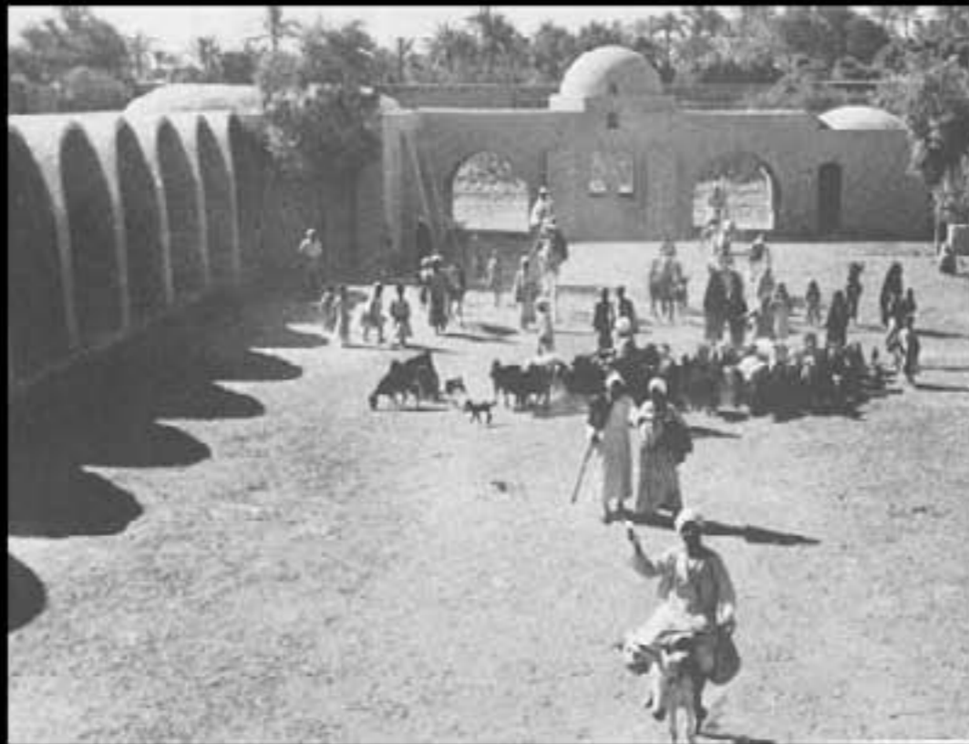
Construction en terre crue
