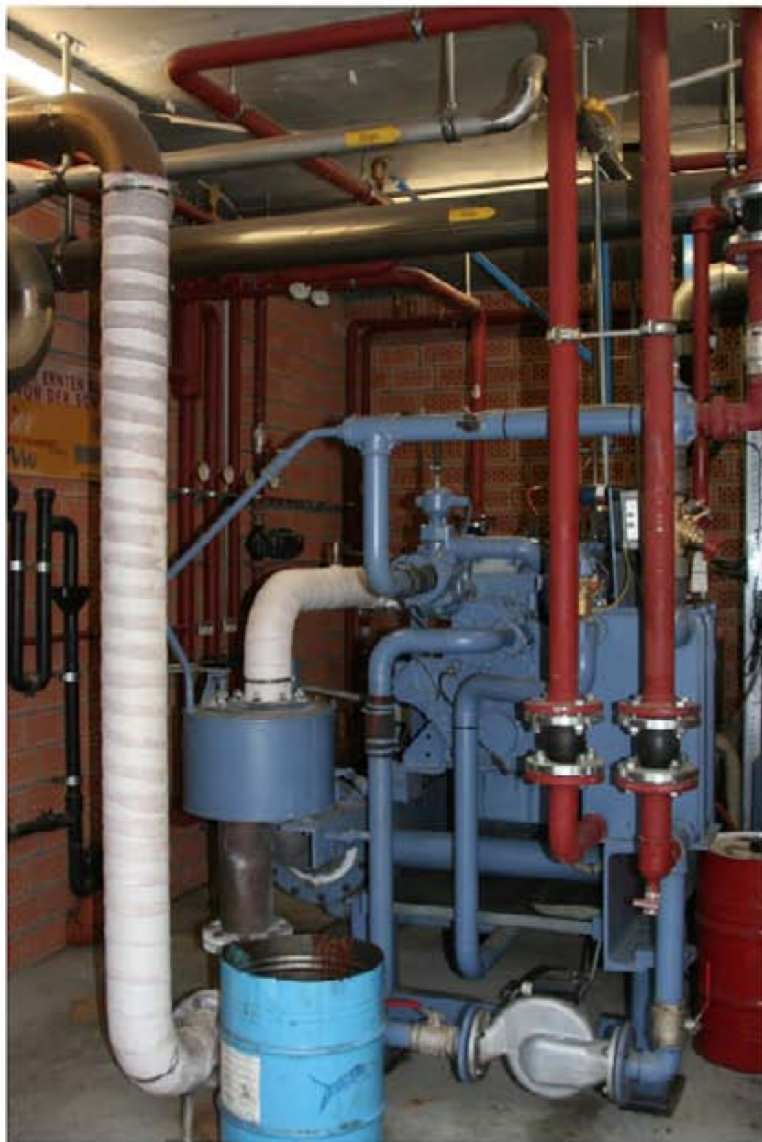
Production de biogaz par les agriculteurs Ferme Ilg à Dornbirn
