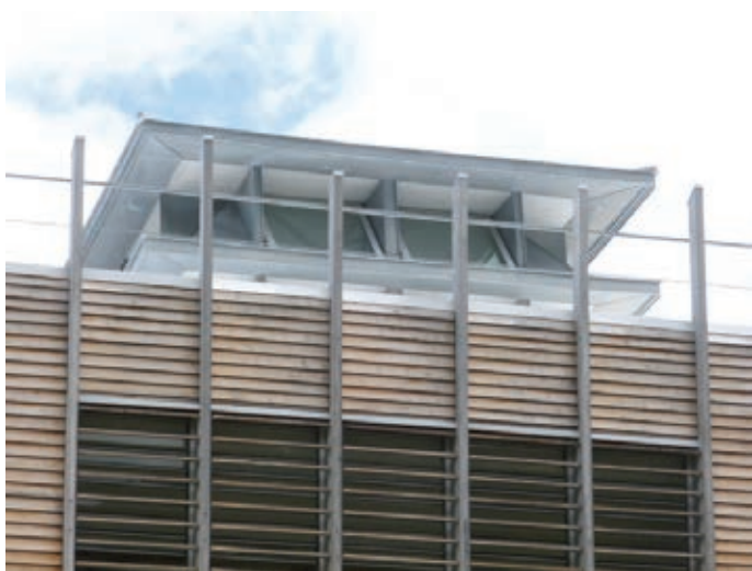
La cheminée dépressionnaire - Principe de fonctionnement
