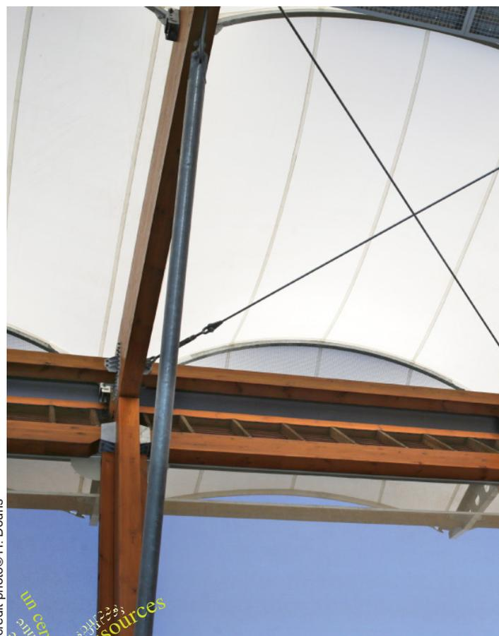
Ossature bois lamellé-collée assemblée par des pièces métalliques galvanisées. Toile précontrainte tendue par les arceaux en métal
