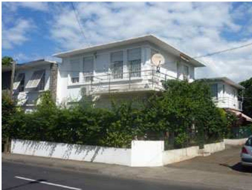
Fig. 65 : Maisons sous dalle béton sans doute non isolée à Saint Denis : le débord assure bien l'ombre mais la thermique ne suit pas...
