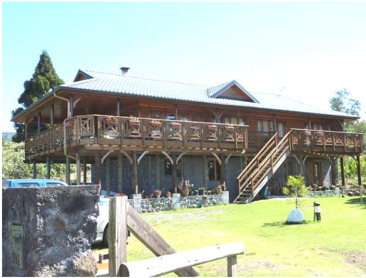
Chambres d'hôtes en ossature bois sur maçonnerie à Bois Court, commune du Tampon.
