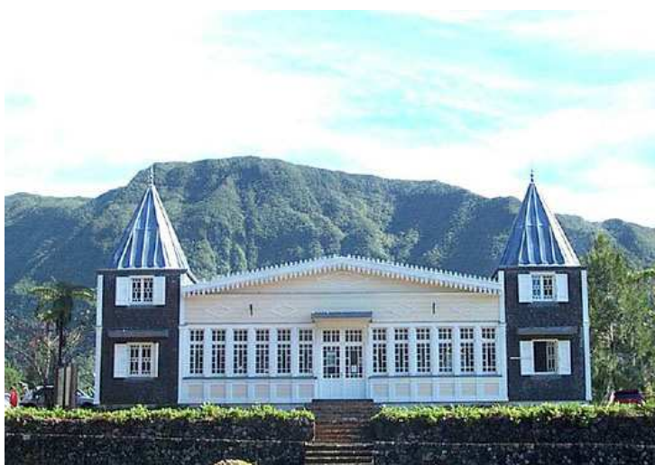
Grande Case à la Plaine des Palmistes (Domaine des Tourelles) : façade SUD-EST
