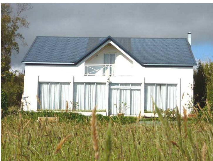
Maison avec véranda intégrée à Bois Court (commune du Tampon), à 1300 m d'altitude) ; la façade est exposée Sud-Ouest.
