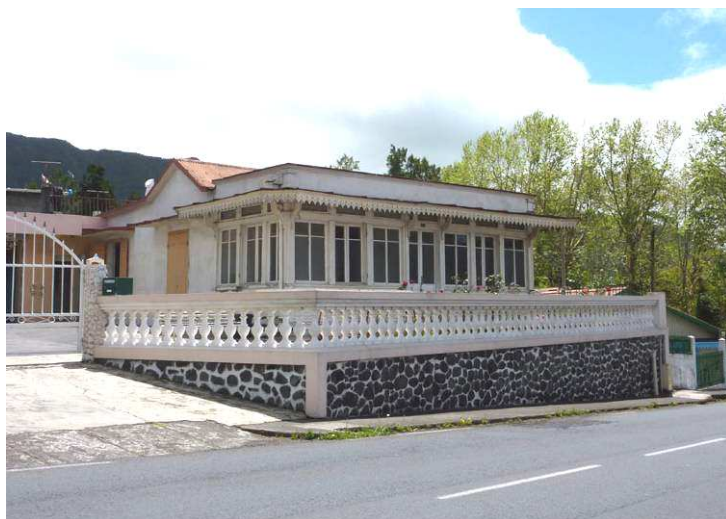
Maison avec véranda accolée à la Plaine de Palmistes (à 1000 m d'altitude) ; la façade est exposée Sud-Ouest.
