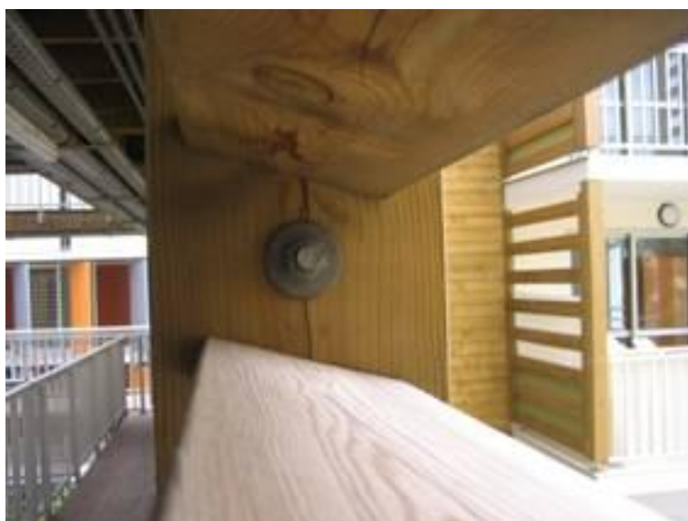
Détail de l'écran de façade des coursives montrant l'inclinaison des lames vers l'extérieur
