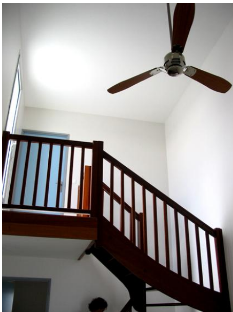
Mise à profit d'une mezzanine pour installer un brasseur d'air plus efficace : logements hauts de l'Ilet du Centre à Saint Pierre (architecte Michel Reynaud)
