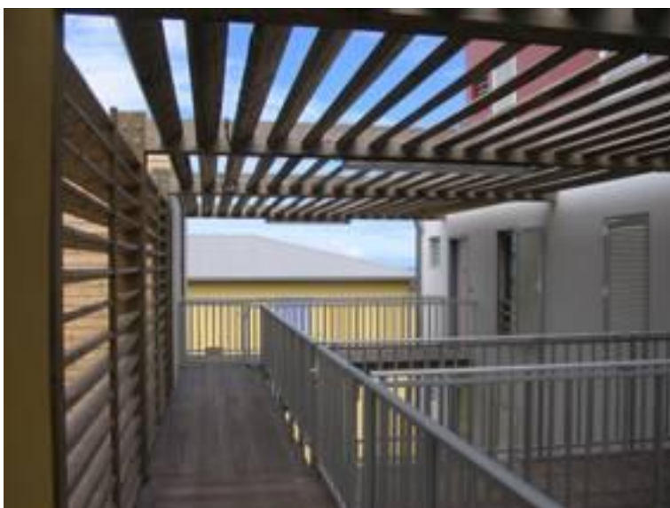
Bâtiment B : la protection en façade et celle en couverture sont visibles à la dernière coursive.
