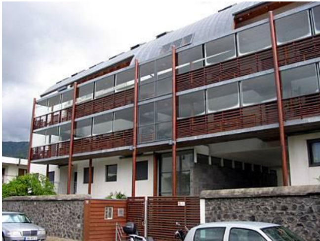
Exemple d'immeuble avec coursives décollées à Saint Denis
