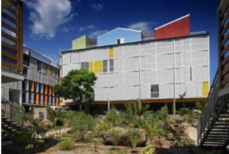
Façade OUEST/NORD-OUEST du bâtiment B : Les persiennes coulissantes des varangues sont presque toutes fermées. Au premier plan, le jardin endémique.
