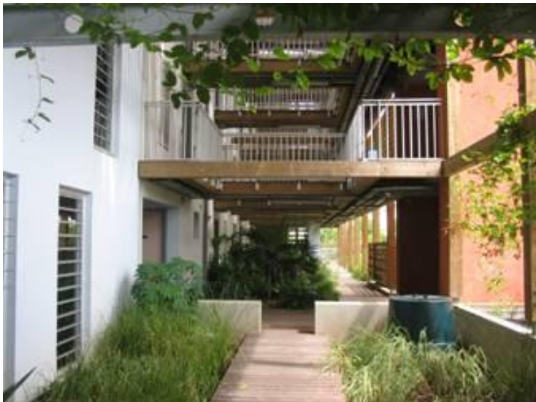
Bâtiment A : coursives de la façade NORD/NORD-EST. La végétalisation concerne aussi les rez de chaussée.
