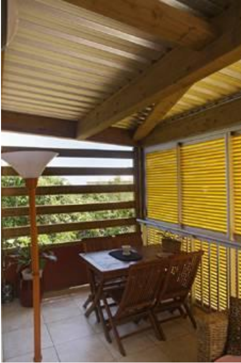
Bâtiment A : Intérieur d'une varangue d'extrémité : on aperçoit les persiennes coulissantes à droite
