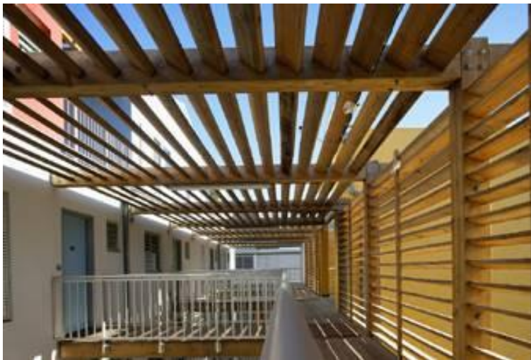
Bâtiment B : Coursive du 3 e étage avec les protections solaires en lames de bois.
