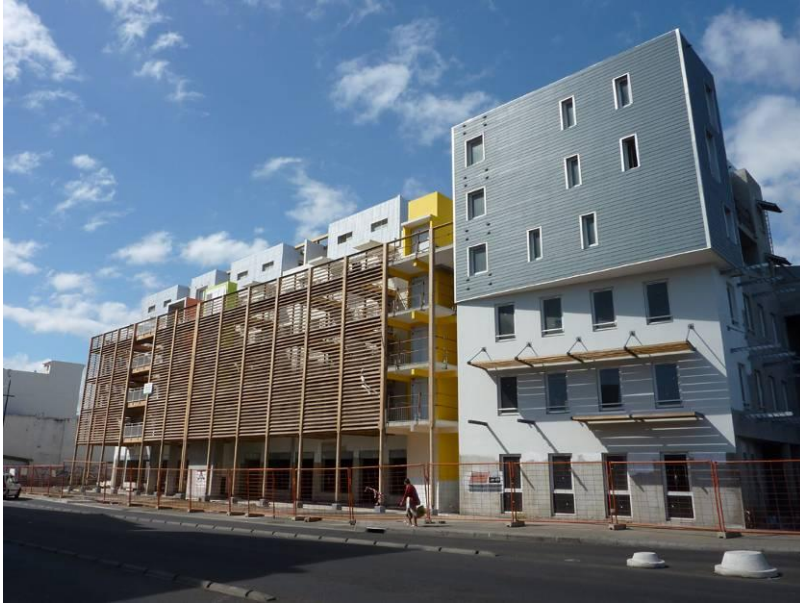
Façade Nord sur le boulevard avec le système de desserte par coursives et passerelles : état du chantier au 27 septembre 2009.
