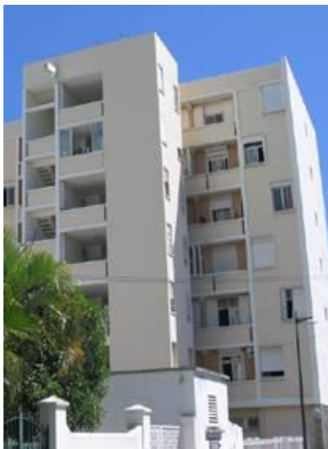
Façade Sud de la Résidence : les « chambres des domestique » forment une surépaisseur du bâtiment avec leur propre circulation verticale aérée.
