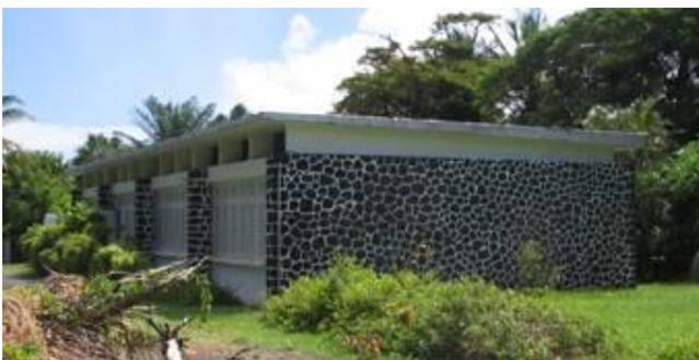
*Il faut noter la grande hauteur sous plafond de 3,10m qui permet une meilleure stratification thermique et autorise l'installation de brasseurs d'air efficaces. L'architecte n'avait pas prévu de brasseurs d'air dans cette résidence, mais la malheureuse transformation partielle de la cuisine en chambre (!) l'a évidemment imposé.*
