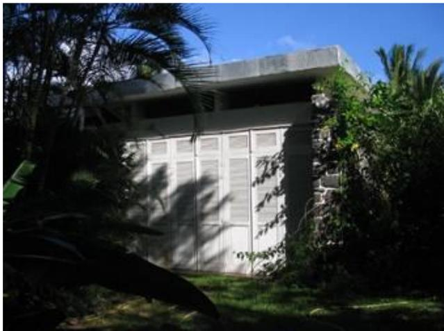
*La porosité de ce matériau à l'eau combinée à l'exposition EST souvent arrosée par la pluie provoque quelques tâches d'humidité à l'intérieur sans toutefois mettre l'ouvrage en péril.*
