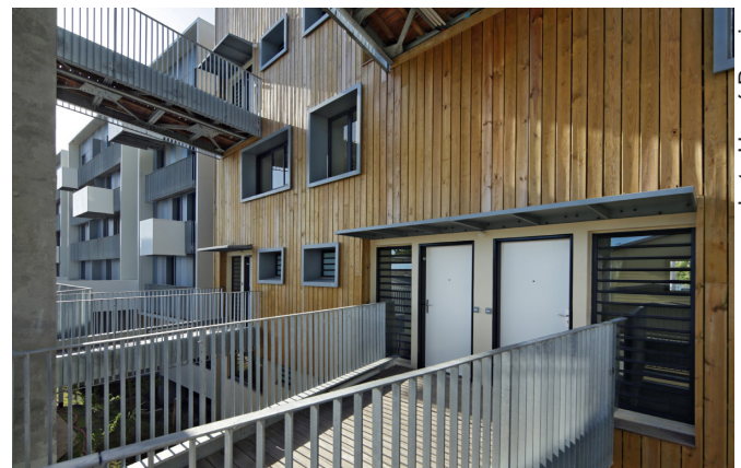
Passerelles métalliques sur façade bois
