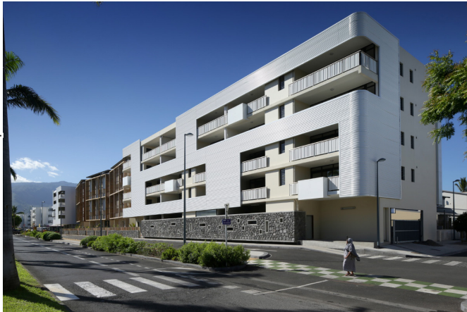
Façade avec varangues sur voie Triomphale
