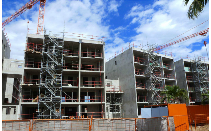
Vue en chantier de la structure béton rationalisée
