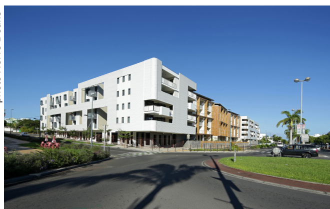
Alignement à l'angle de l'av. Paul Vergès et Lénine
