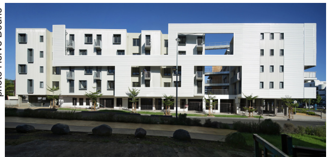
Façade avenue Lénine
