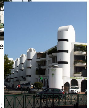
Angle face à l'opération:
