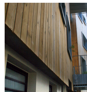
Pied de citrouille montrant l'appropriation du jardin commun et détail de la double peau ventilée
