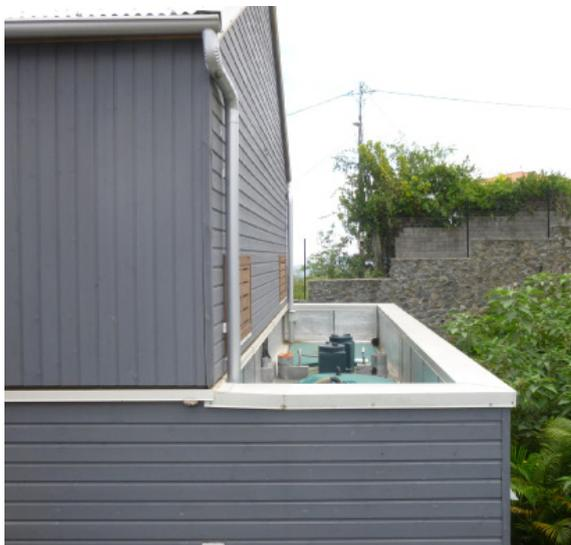
Système de récupération et stockage des eaux pluviales
