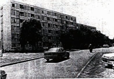
Construit en 1973, le groupe d'habitations Vauban 1 est exposé au bruit (photos Frédéric ALLAMELOU).
