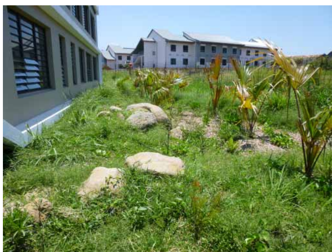
Noue d'infiltration des EP
