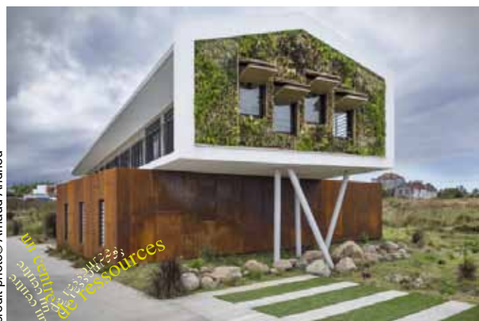
Pignon ouest en sphaigne et stock en acier corten (rappel de l'aspect de l'usine de Pierrefonds)
