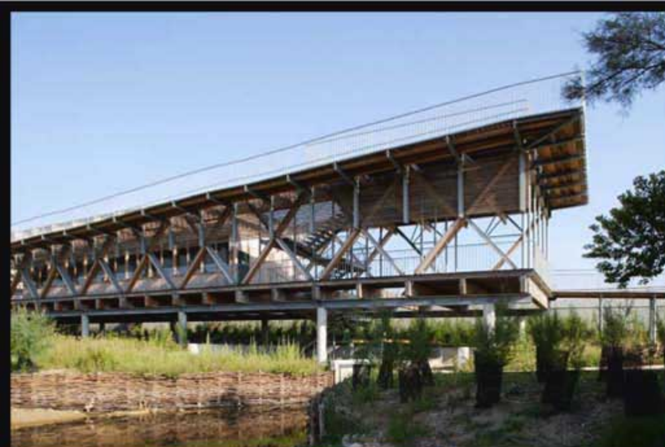
La vanne, l'arrivée des rampes et le belvédère
