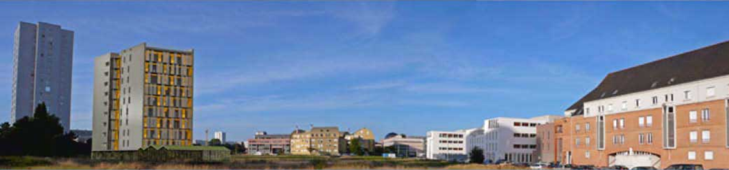
2007—... 40 logements sociaux BBC Effinergie à Nantes (44)
