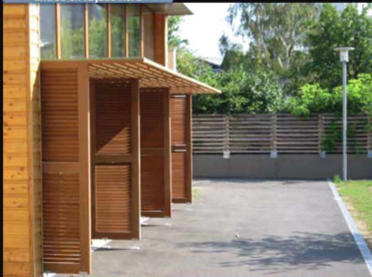
Détail de la protection solaire des serres de la façade Sud
