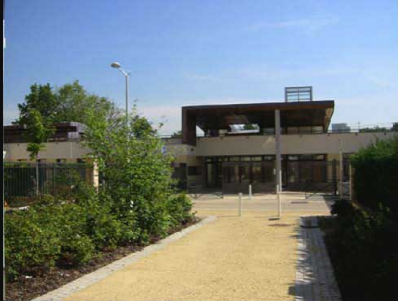
Entrée en façade Nord
