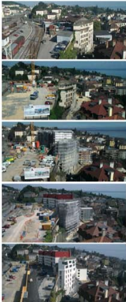
Phases successives de la construction des logements dont extensions au dessus de l'existant
