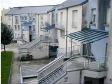
Besançon, rue des hauts de Saint-Claude, n° paire, 27 logements PLA, 1996, MO : Habitat 25, archi : Gilles Bruno.
