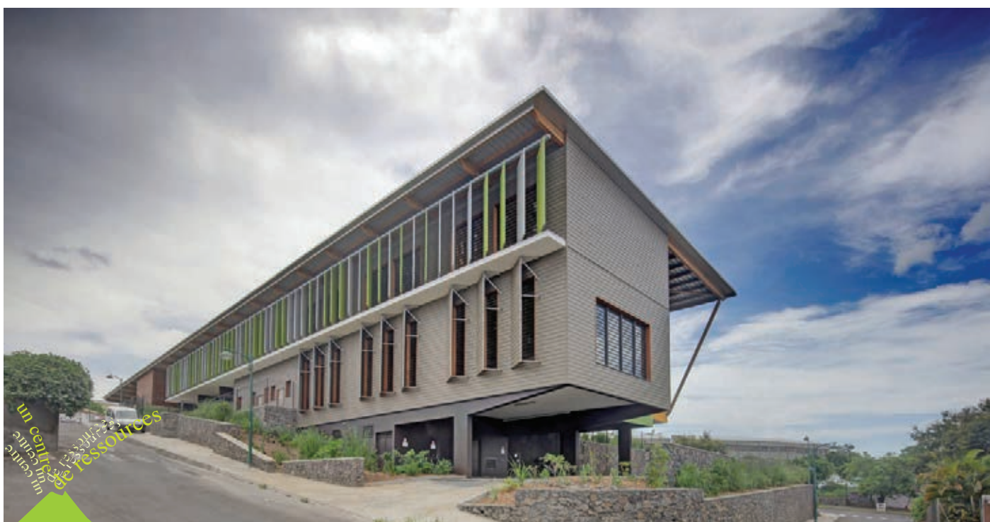
Le bâtiment émerge petit à petit du talus pour former porte-à-faux permettant au passage de loger les voitures.
