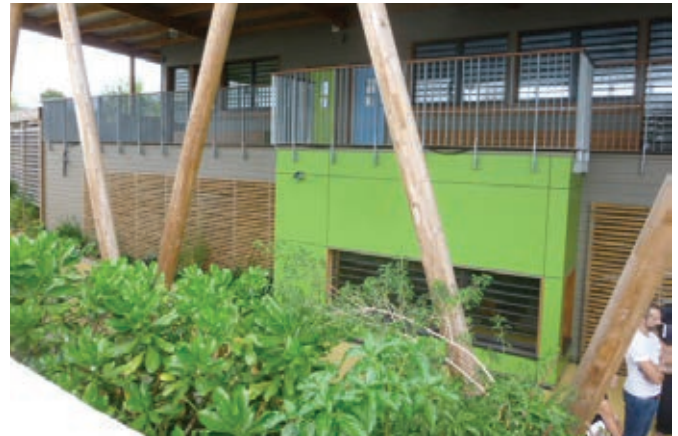
Tampon végétal sur rue des Oliviers
