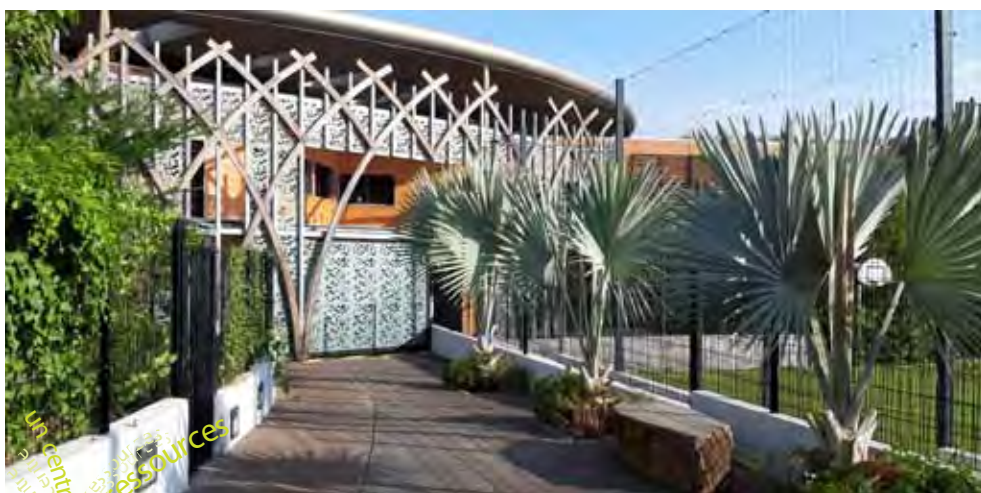
▽ La double peau en façade Est sur l'entrée protège et identifie le bâtiment
