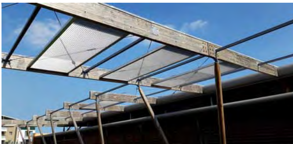
△ La surtoiture se mue en ombrière en débordant sur la cour
