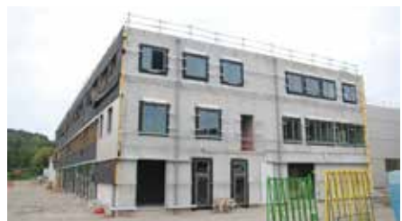
Le futur bâtiment des Archives en cours de construction
