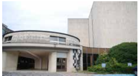
L'actuel bâtiment des Archives Départementales 02
