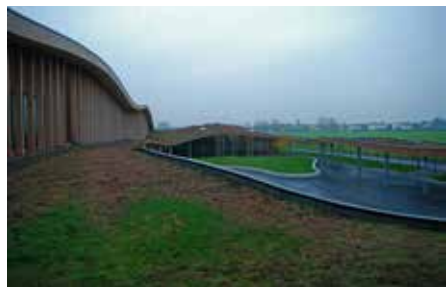
Toiture plantée et parement de bois au collège Froëhlicher de Sissonne
