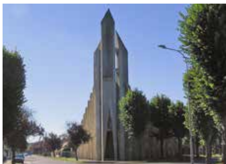
L'église St Crépin à Soissons, identifiée pour recevoir le Label «Architecture contemporaine remarquable».
