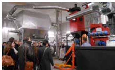
Visite de la chaudière bois au collège de Sissonne
