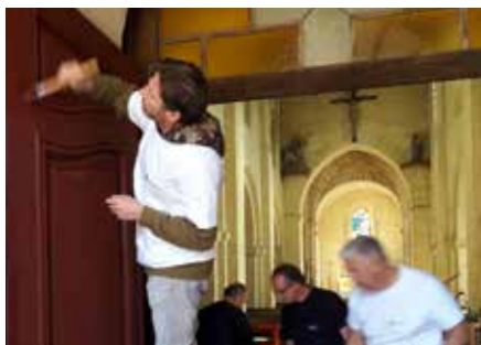
Mise en peinture de la porte de l'église de Ressons-le-Long
