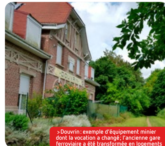
> Pecquencourt: exemple de logement minier, protégé, rénové et restructuré, qui garde sa vocation de logement
