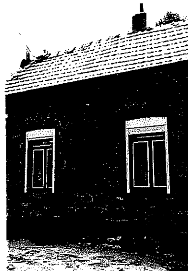
Bâti rural traditionnel longeant la Ruelle
