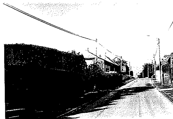
Séquence N° 4: Effet de surplomb ou d'encastrement du Bâti Accotements minéralisés, Nombreux Réseaux aériens
