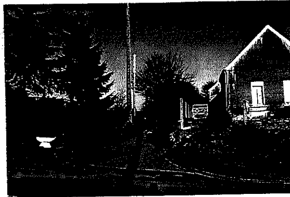
Perception de la Rue Gros depuis l'Ouest Evasement du débouché et ponctuation par du Végétal public
