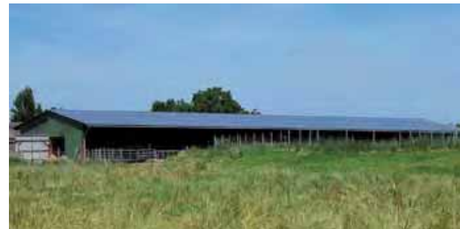
Toit photovoltaïque sur stabulation, St Pierre d'Eyraud, 2010
