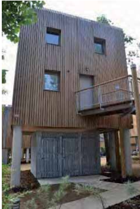
Locaux à vélos et poussettes sous les logements
