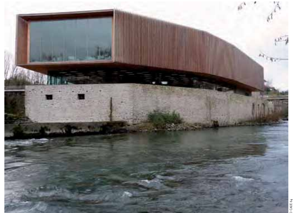
La médiathèque sur les gaves
