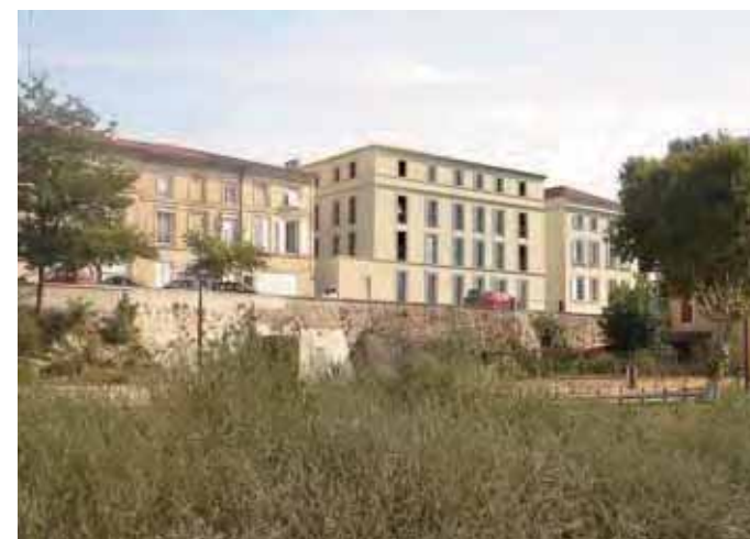
Bâtiment de 12 logements et RPA de 25 logements
