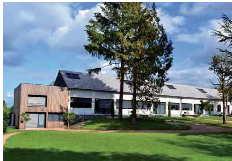
La façade principale accessible par les personnes à mobilité réduite
