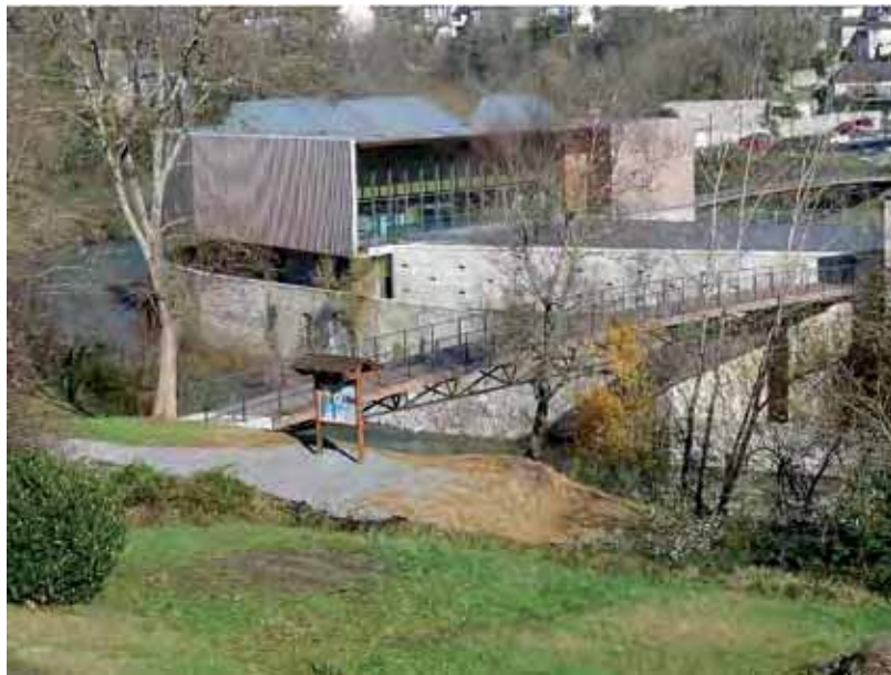
Une des deux passerelles sous-tendues
