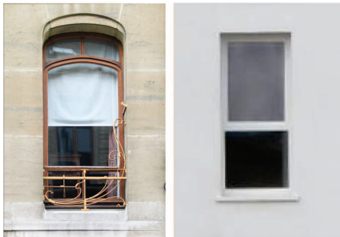
Figure 12 : Comparaison de deux procédés constructifs d'une fenêtre (art nouveau et moderne/contemporain) utilisée par David Orbach dans une conférence donnée en 2015
