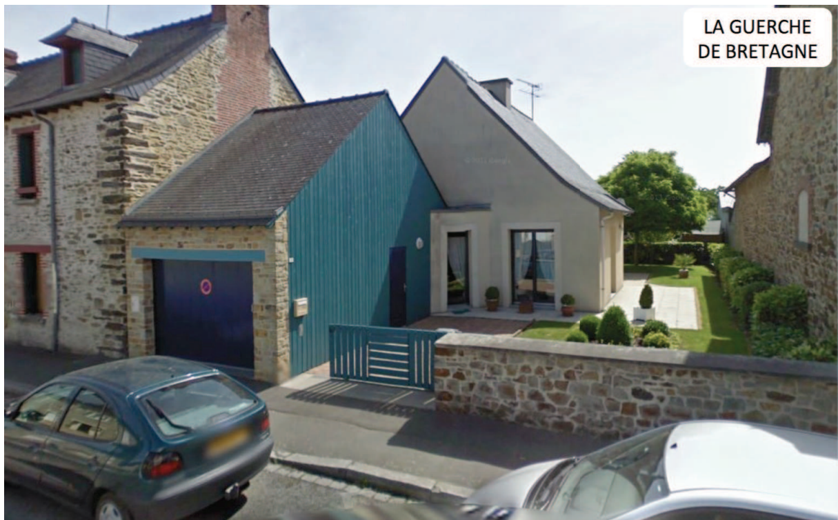
Figure 21 : Exemple de construction d'un nouveau logement sur mesure. (Capture d'écran Google Street View à La Guerche-de-Bretagne, 2014)
