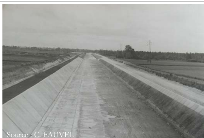
- Canal du Nord en construction -
