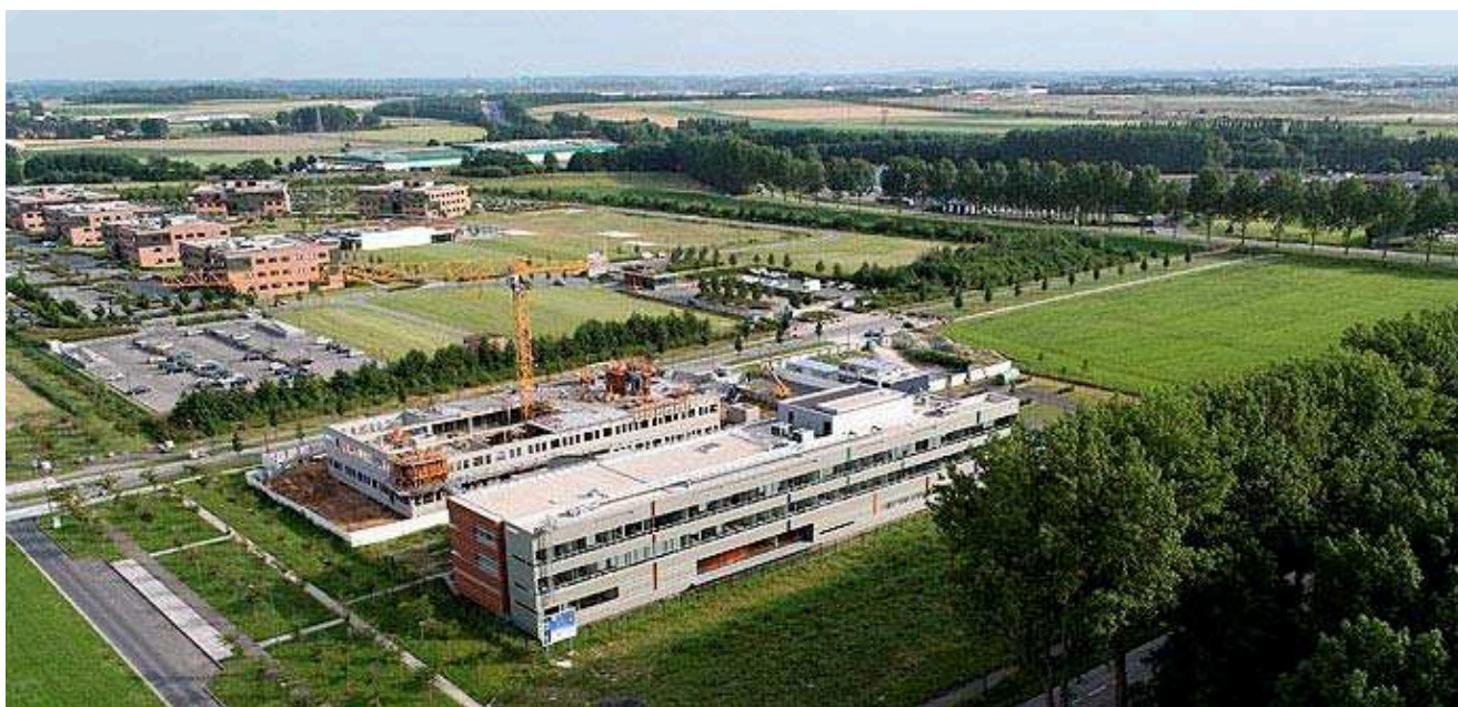
III. 40 : Vue aérienne des bâtiments de l'IRCICA et de l'IRI en construction — 06/2007 (©SAEM Haute Borne)
