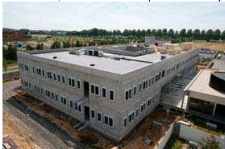
iii. 38 : Chantier de l'IRI — 08/2007 (© IRI)
