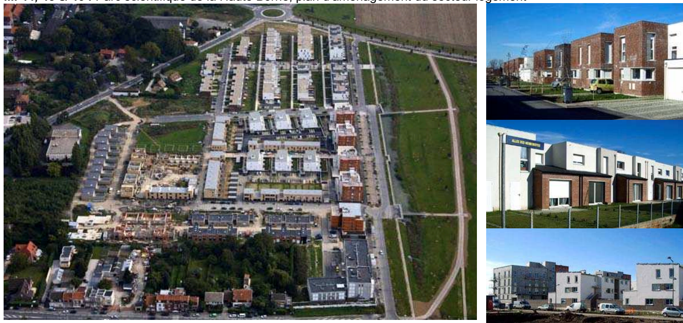
ill. 47, 48, 49 & 50 : Parc scientifique de la Haute Borne, Secteur Habitat, vue aérienne, (©SAEM Haute Borne)
