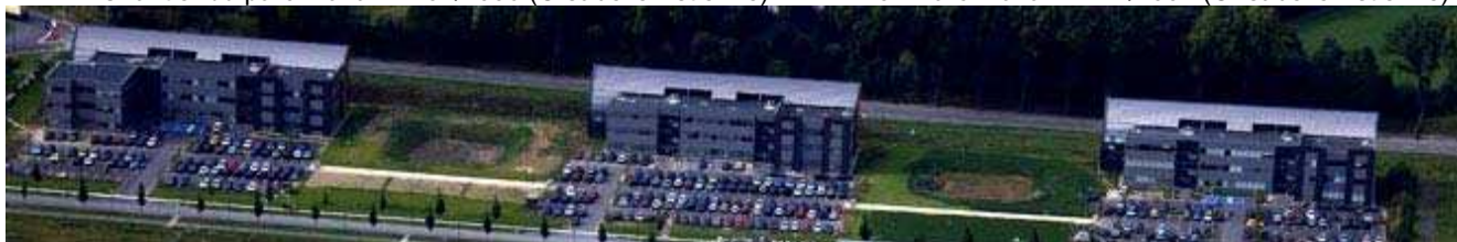
ill. 24 : Parc Plaza I, vue aérienne — 09/2007 (©SAEM Haute Borne)
