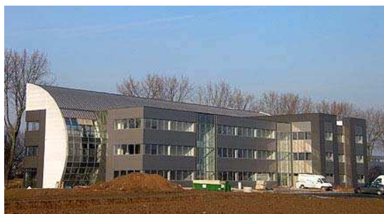
ill. 22 : Chantier du parc Plaza I — 01/2006 (©Isabelle Estienne)
