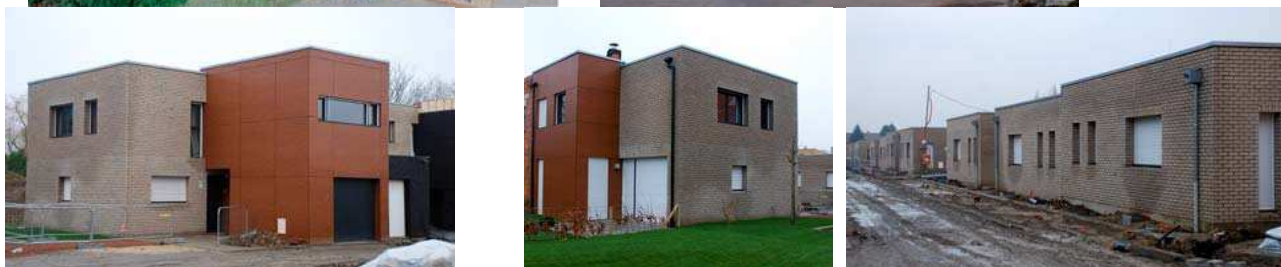
iii. 56 - 60 : Lot n° 1 : maisons individuelles en chantier — 12/2007 (© Isabelle Estienne)
