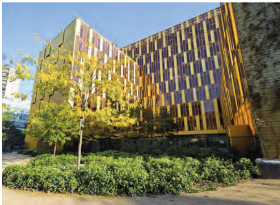
Figure 1 : Un exemple de mixité. Ouvert sur la Seine et sur les coteaux de Sèvres et de Meudon, le Trapèze est conçu comme un quartier diversifié et vivant qui comptera à terme plus de 12 000 habitants et 12 000 salariés. © Arnaud Bouissou/METL-MEDDE
