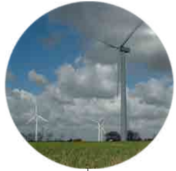
Un parc éolien
