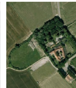
Ferme Aigremont à Ennevelin © Google
