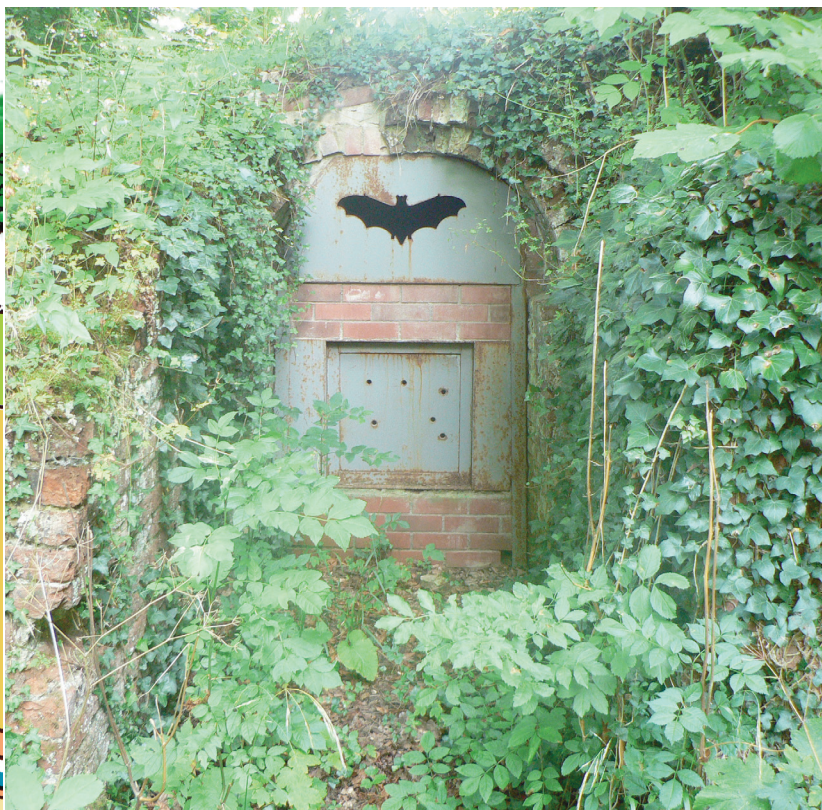
Le retraitement de l'entrée de la glacière ne porte pas les valeurs architecturales du parc et de ses vestiges. Néanmoins, ce nouvel usage témoigne des qualités écologiques du domaine.
