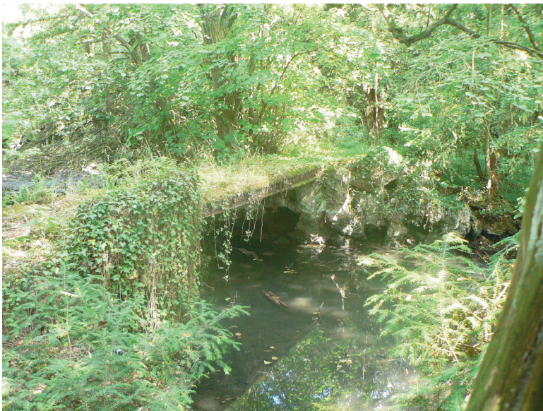
Menant de la petite île aux berges de la serpentine, le pont rustique a perdu toute son originalité et n'est plus qu'une passerelle de béton et d'acier, néanmoins portée par des enrochements de la période Boutry.
