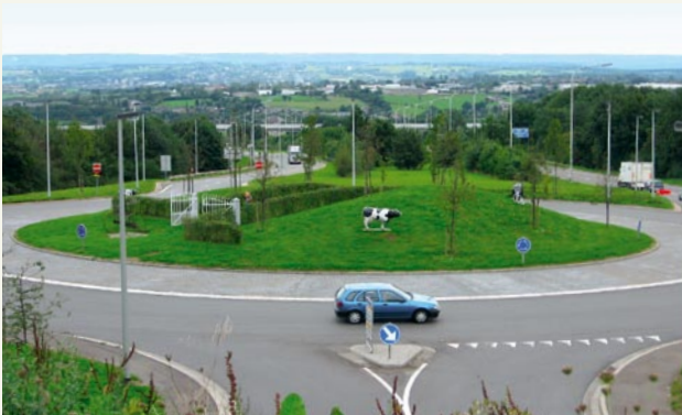
Battice marque une rupture avec son rond-point et sa descente d'accès à l'autoroute. C'est à ce moment que l'on accède à un paysage plus rural. Photo : A. Vandenberg.
