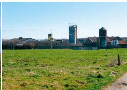
Les fermes encore en activité ont vu des tours et silos modernes modifier leur silhouette ancienne.
