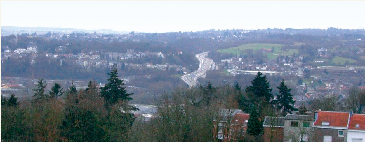
L'autoroute au sud de Verviers, vue depuis Lambermont.
