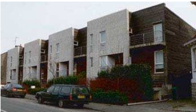
ill. 8 : Opération « Face sur rue », rue Jean Jaurès à Croix, Escudié – Fermaut architectes, 1998
