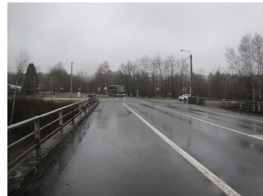
Pont au nord du site
