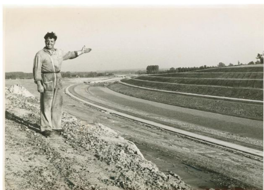
«La construction du grand Canal vers 1959-1960 présentée par Natale, un ouvrier du chantier.» source: http://www.maubray.be/
