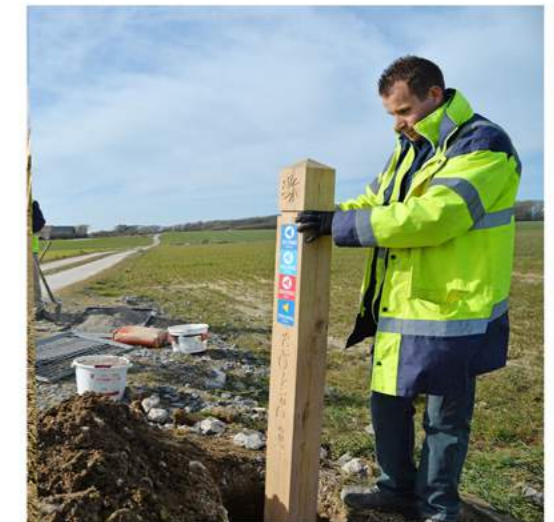
Chantier d'insertion : mise en place du balisage randonnée
