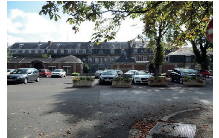
La lisibilité architecturale brouillée par le stationnement sauvage
