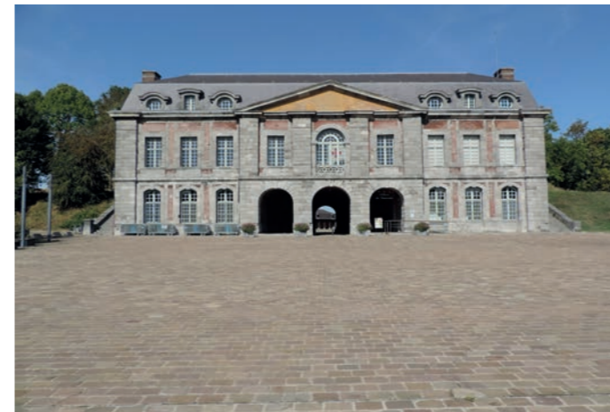
Une place qui met en valeur la Porte de Gand
