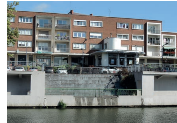
Quai et ponton sur du Mail de la Sambre
