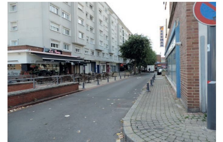
Un accès direct depuis la place des Nations
