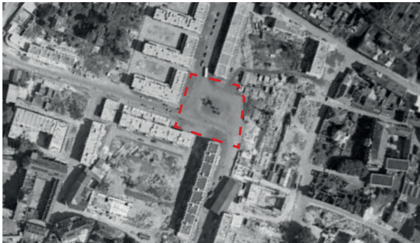
Place des Nations en 1950 : une place déjà centrale après guerre
