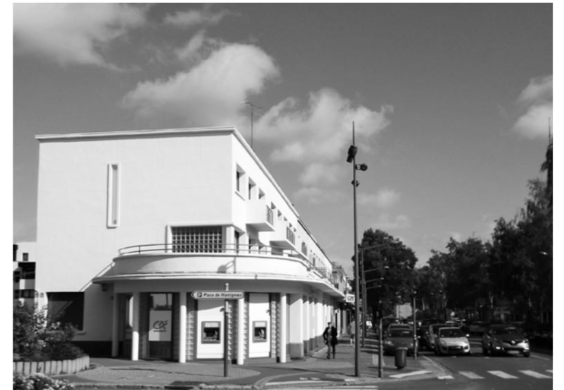
Avenue de France
