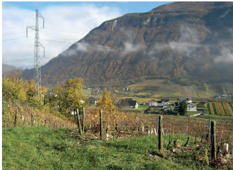
Groupe 3 : « Altération d'un équilibre par des éléments perturbant liés à l'augmentation de population : lotissement pavillonnaire de bâtiments disparates. Présence d'un poteau électrique »
