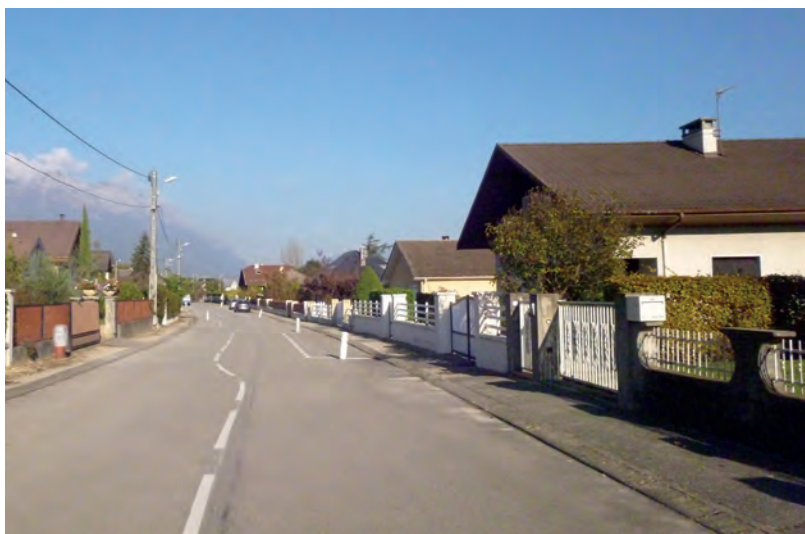
Un lotissement «linéaire» des années 70 avec une logique assez routière mais très ouverte sur l'espace public
